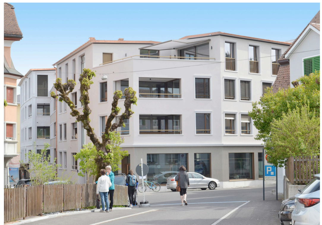
Südfassade, Blick von der Werner-Kälin-Strasse.
