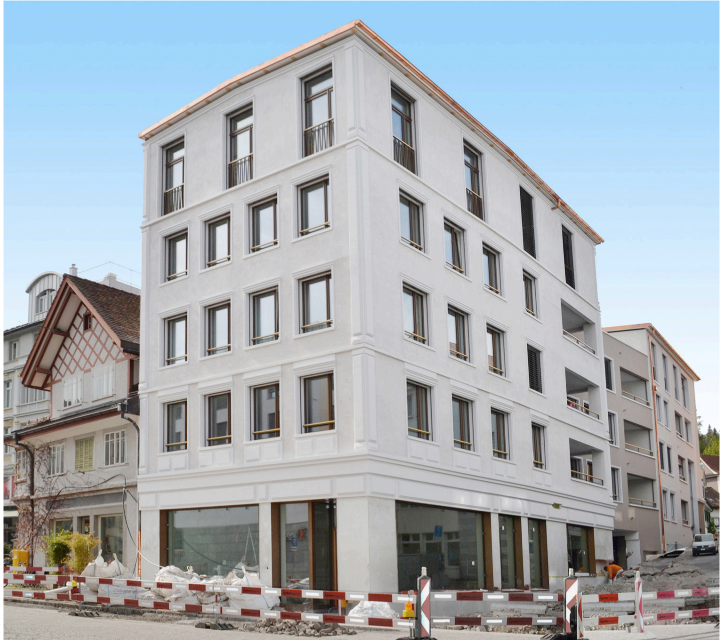
Hauptfassade vor Fertigstellung.
