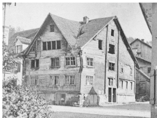
Das sogenannte «Specklihaus» kurz vor seinem Abbruch.
